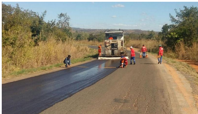
Figura 3: Aplicação da lama asfáltica
