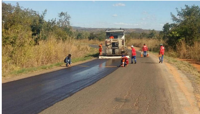
Figura 3: Aplicação da lama asfáltica
